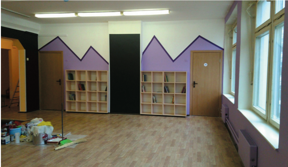
Рис. 69. Зона делового общения в процессе ремонта
