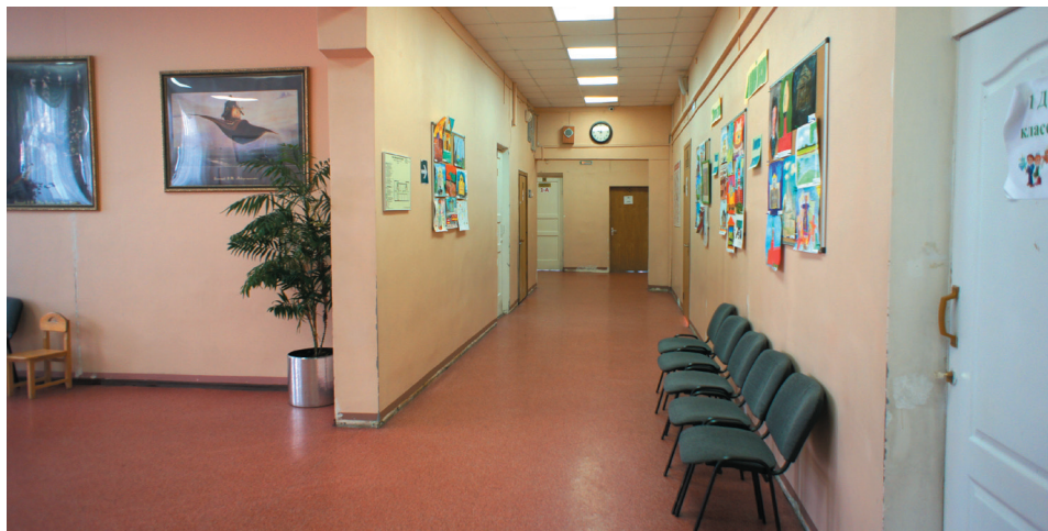
Рис. 78. Коридор 2-го этажа до ремонта
